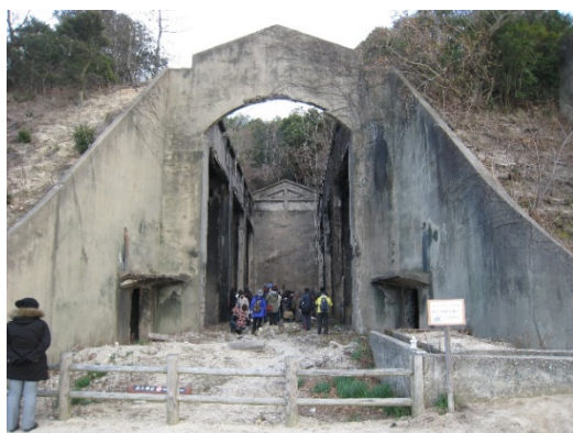
毒ガス貯蔵庫跡
